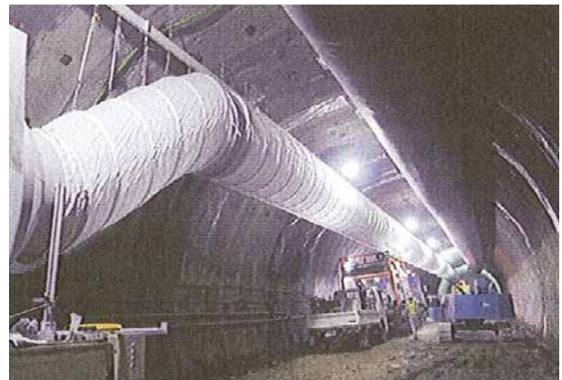
伸縮風管接続完了
