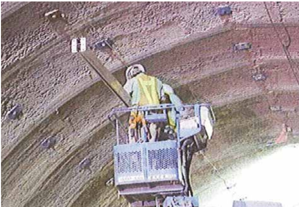
レール設置状況
