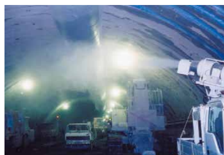
バズーカノズル+SFファン+専用架台
