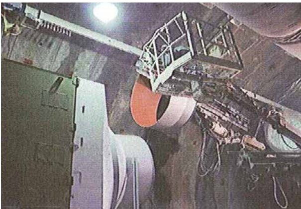
曲がり管設置状況
