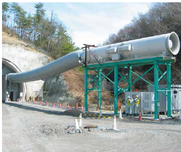
シングル型ビッグ・ログ：モータ直動型（局所送気用等）
