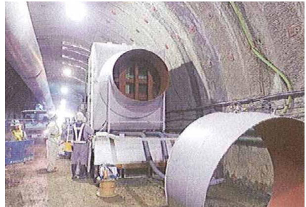
集塵機接続管の設置
