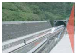
鉄道施設／侵入検知
