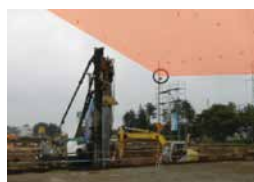
高圧線直下作業／空頭検知
