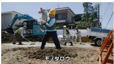
建設工事②
