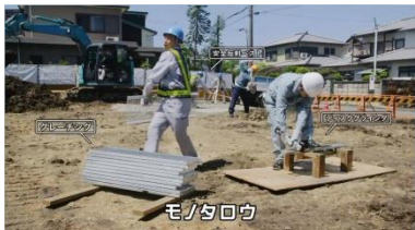
建設工事①
